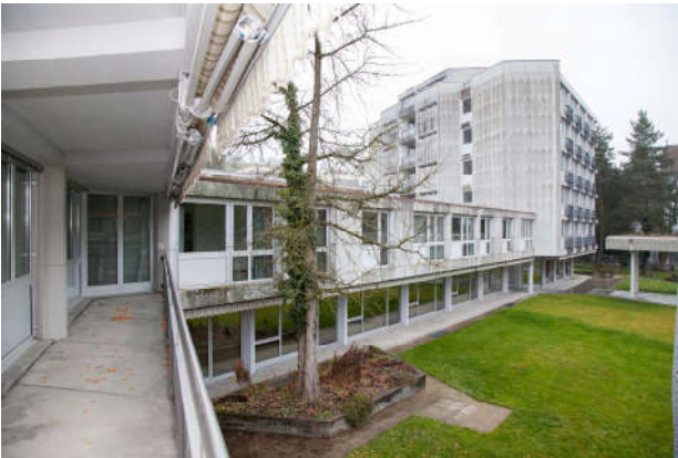
November 2015: Der leer geräumte Rosenberg kurz vor Baubeginn.
