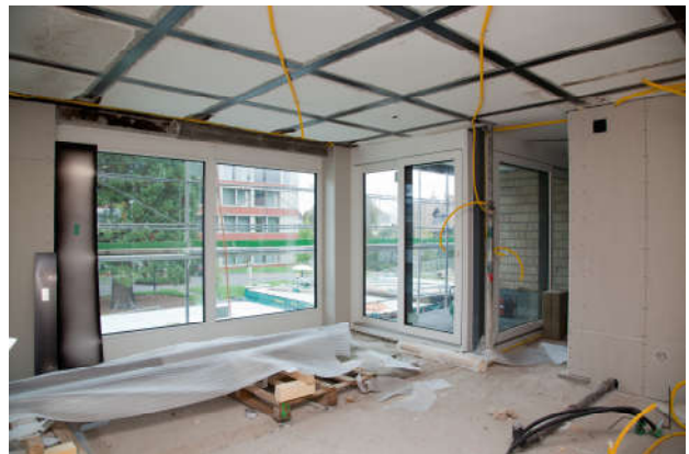
September 2016: Die Mietwohnungen (hier mit Loggia) nehmen immer mehr Gestalt an.
