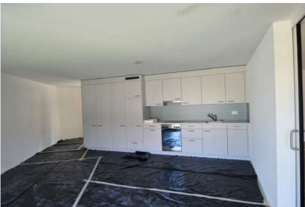
März 2017: Die Küchen und Badinstallationen werden eingebaut.
