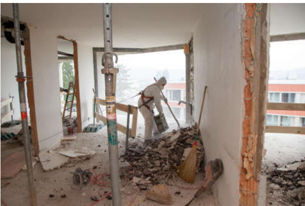
März 2016: Wände werden herausgebrochen und neue Innenmauern errichtet.
