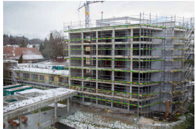
Februar 2016: Gerüste zieren den Rosenberg-Turm und die Balkone werden angebracht.
